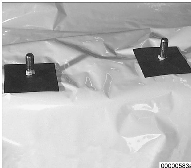
7. Для дополнительной защиты алюминиевой фольги наложить на эбонитовые пластины пенополиэтиленовый лист.
